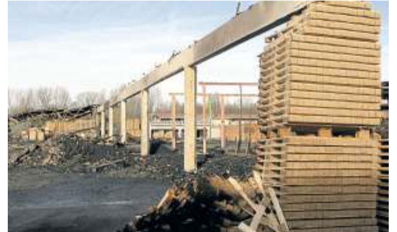
Der Tag nach dem Brand im Dezember 2013. Viel stand nicht mehr von der früheren Produktionshalle. Schaden: rund 8,5 Millionen Euro. Foto/Archiv: Grohmann
